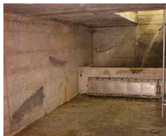
Figura 46. Invasi di laminazione realizzati con interventi "verdi" (a) o con vasche chiuse in calcestruzzo (b).
