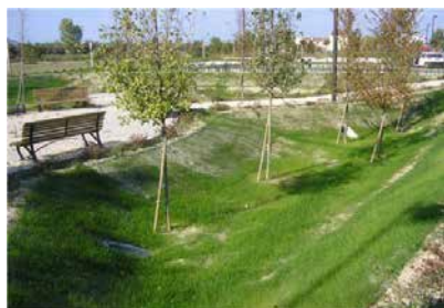
Figura 46. Invasi di laminazione realizzati con interventi "verdi" (a) o con vasche chiuse in calcestruzzo (b).
